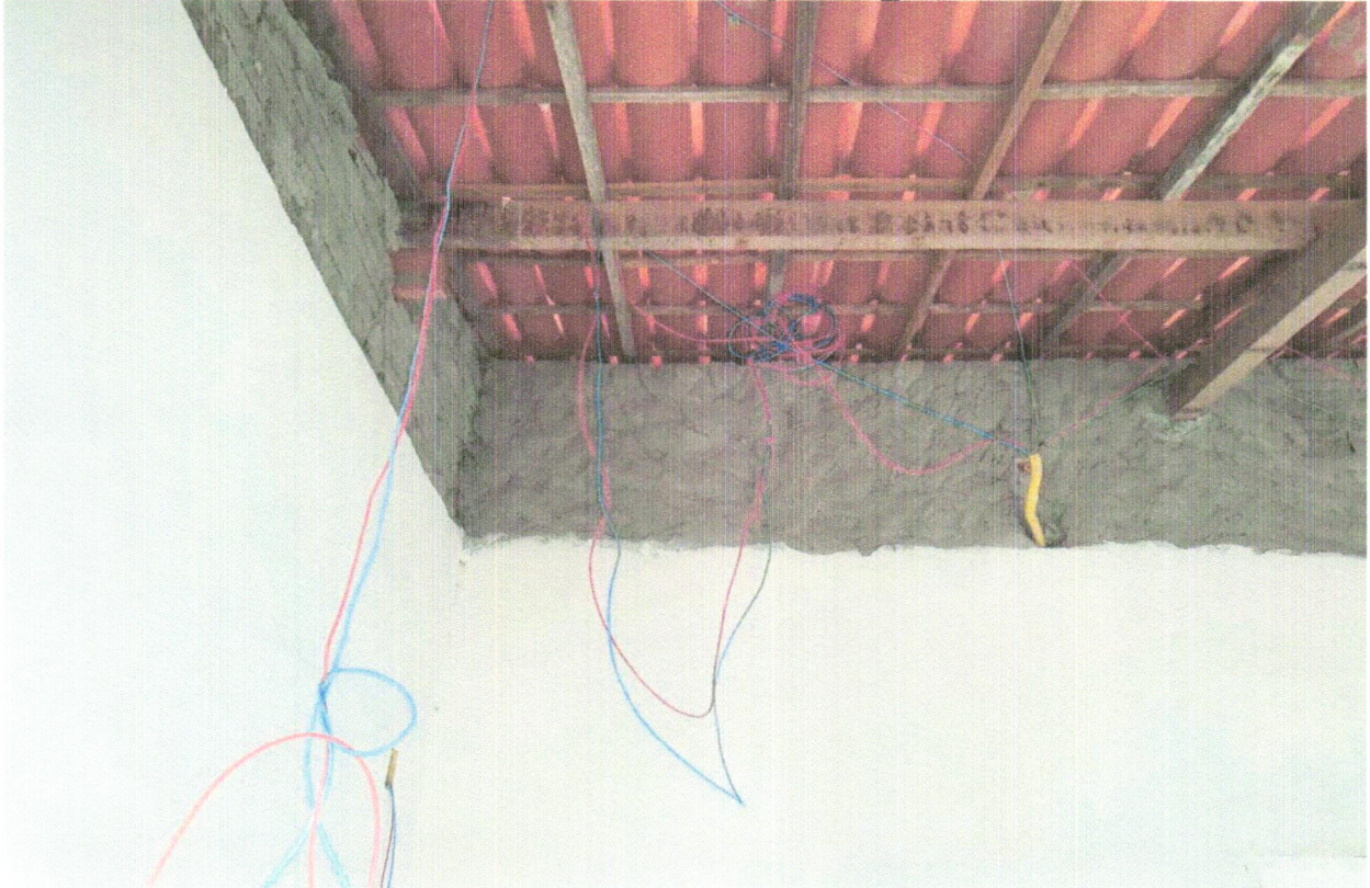
FOTO 14 - CABO DE COBRE FLEXÍVEL ISOLADO, 2,5 MM 2 , ANTI-CHAMA 450/750 V, PARA CIRCUITOS TERMINAIS - FORNECIMENTO E INSTALAÇÃO. AF_12/2015
