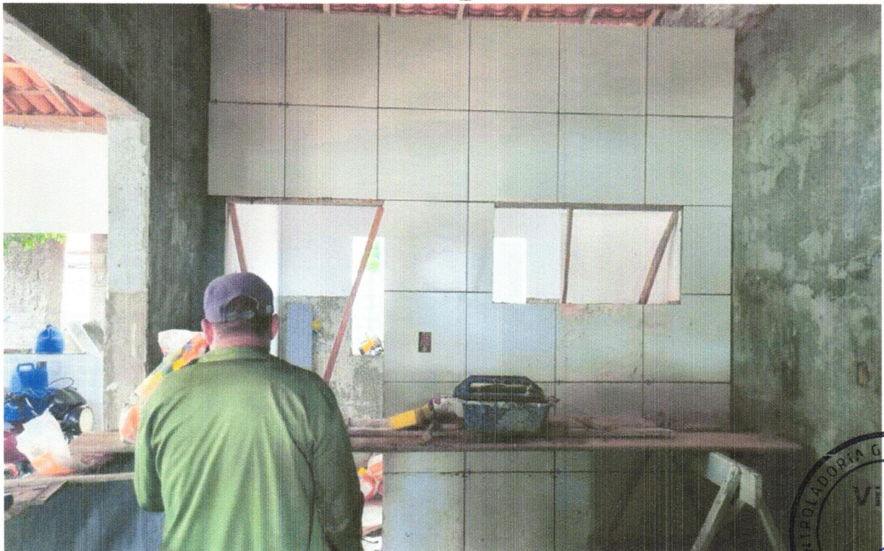
FOTO 16 - REVESTIMENTO CERÂMICO PARA PAREDES INTERNAS COM PLACAS TIPO ESMALTADA EXTRA DE DIMENSÕES 33X45 CM APLICADAS EM AMBIENTES DE ÁREA MAIOR QUE 5 M 2 NA ALTURA INTEIRA DAS PAREDES. AF_06/2014
