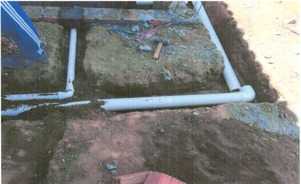
FOTO 04 - TUBO PVC, SERIE NORMAL, ESGOTO PREDIAL, DN 100 MM, FORNECIDO E INSTALADO EM RAMAL DE DESCARGA OU RAMAL DE ESGOTO SANITÁRIO. AF_12/2014
