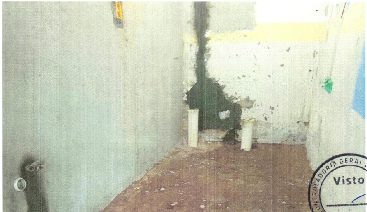
FOTO 02 - PONTO DE ESGOTO COM TUBO DE PVC RÍGIDO SOLDÁVEL DE Ø 100 MM (VASO SANITÁRIO)
