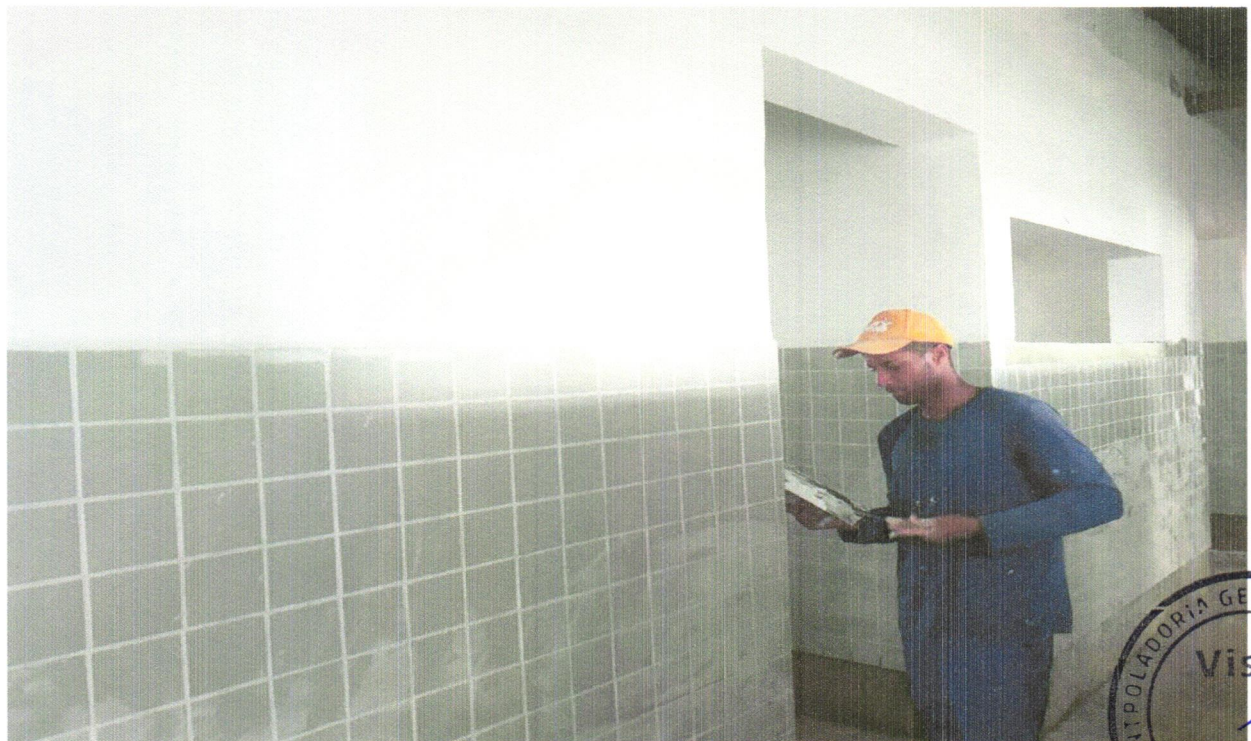
FOTO 24 - APLICAÇÃO E LIXAMENTO DE MASSA LÁTEX EM PAREDES, UMA DEMÃO. AF_06/2014
