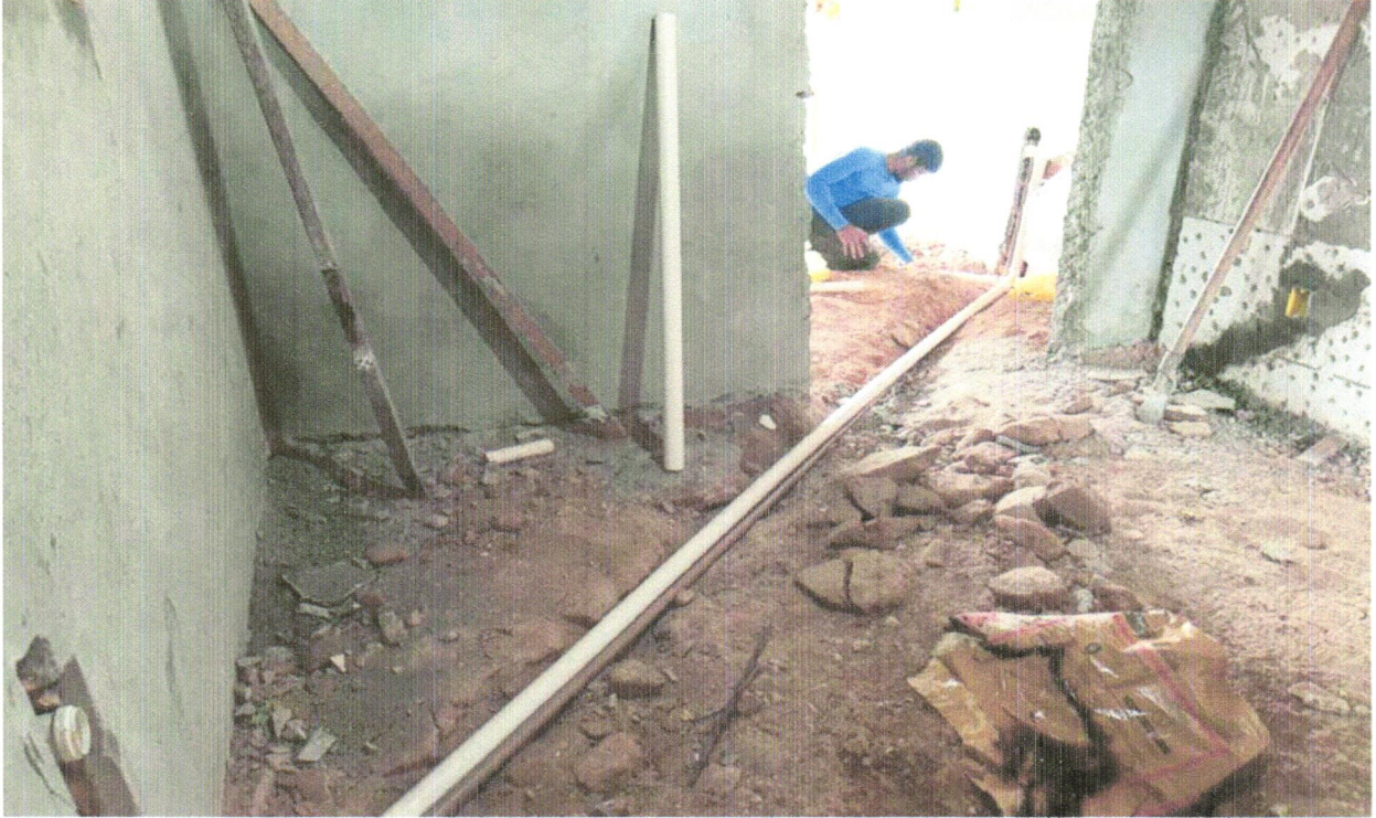
FOTO 06 - PONTO DE ESGOTO COM TUBO DE PVC RÍGIDO SOLDÁVEL DE Ø 40 MM (LAVATÓRIOS, MICTÓRIOS, RALOS SIFONADOS, ETC...)
