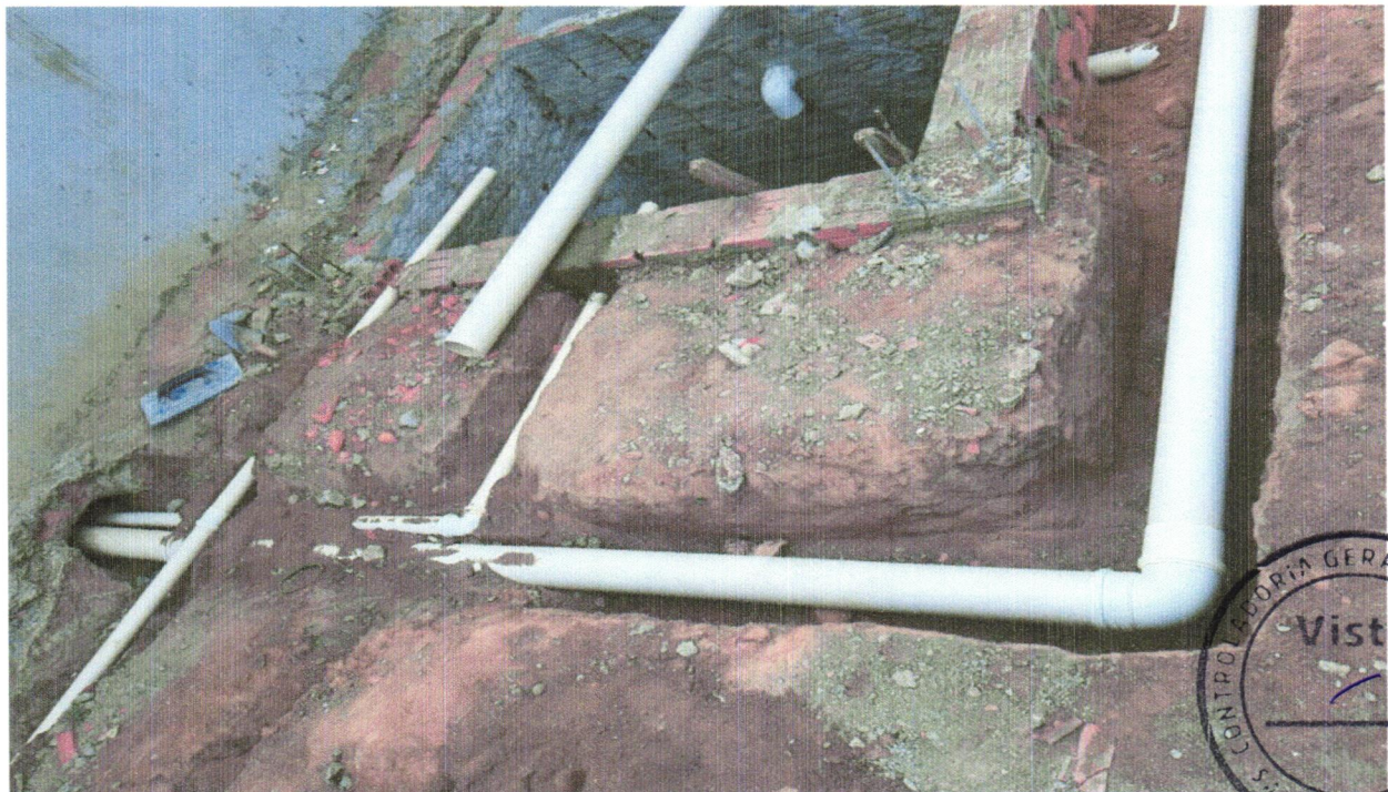
FOTO 04 - TUBO PVC, SERIE NORMAL, ESGOTO PREDIAL, DN 100 MM, FORNECIDO E INSTALADO EM RAMAL DE DESCARGA OU RAMAL DE ESGOTO SANITÁRIO. AF_12/2014
